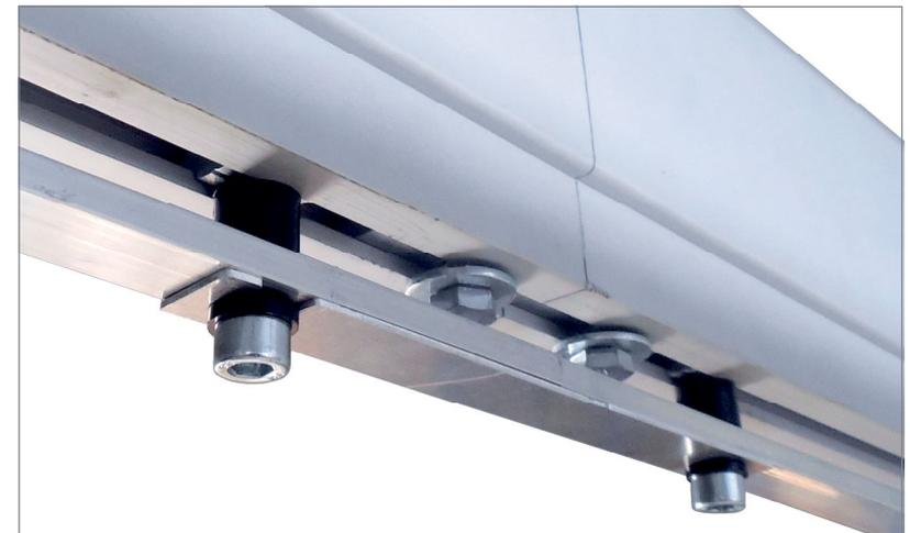
La base «extrémité butée rail arrêt» est composée d'un support en aluminium sur lequel est collé une mousse côté chariot pour amortir en cas de choc du chariot.
